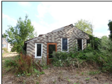
Figuur 4. Vooraanzicht opstal 2, kijkrichting noord.
