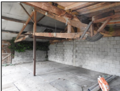
Figuur 6. Binnen aanzicht opstal 2, kijkrichting noord.
