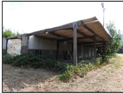
Figuur 10. Aanzicht opstal 6, kijkrichting noordoost.
