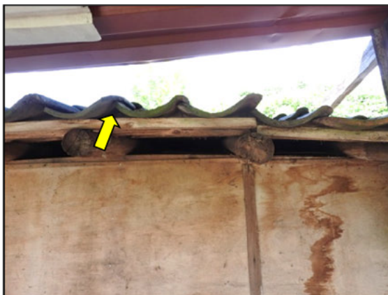
Figuur 18. Ruimte tussen de betimmering en dakpannen waar huismus en vleermuizen gebruik van kunnen maken.
